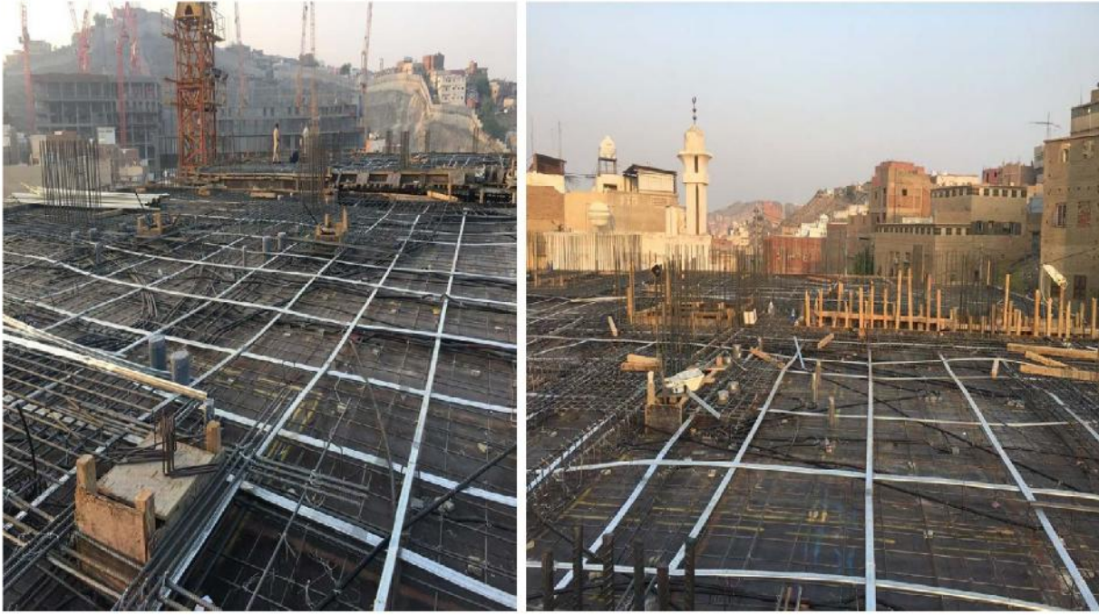
أعمال حدادة الأسقف لاحقة الشد لدور المتكرر الثاني
