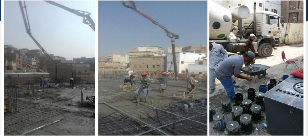
أعمال الصب للسقف وأخذ عينات الأختبار في دور المتكرر الثاني
