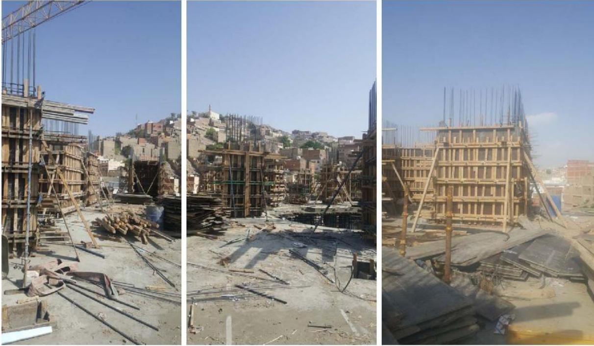
أعمال التقويات و ضبط الوزنات لنجارة أعمدة دور المتكرر الثاني
