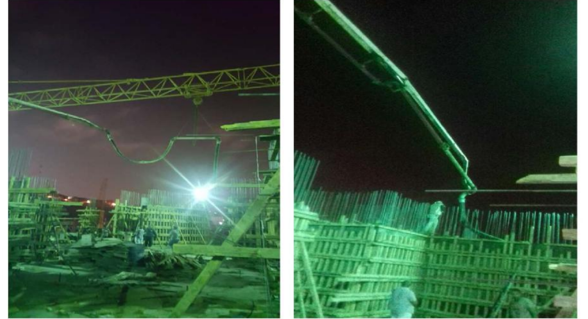
أعمال الصب لأعمدة دور المتكرر الثاني
